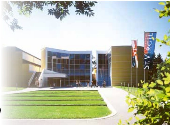
Eingangsbereich St. Virgil Salzburg
